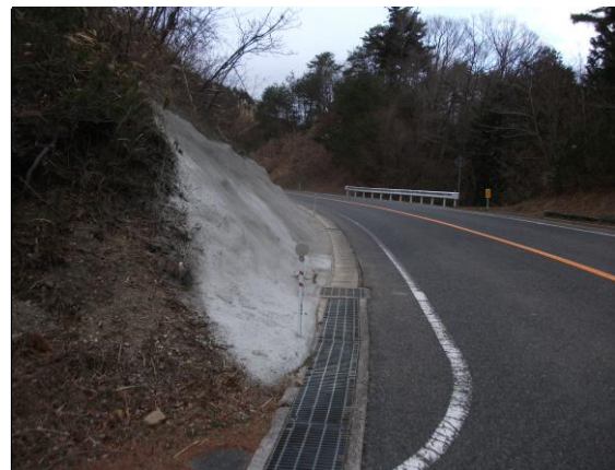
東納庫地区 農道(法面)改良工事 完了
