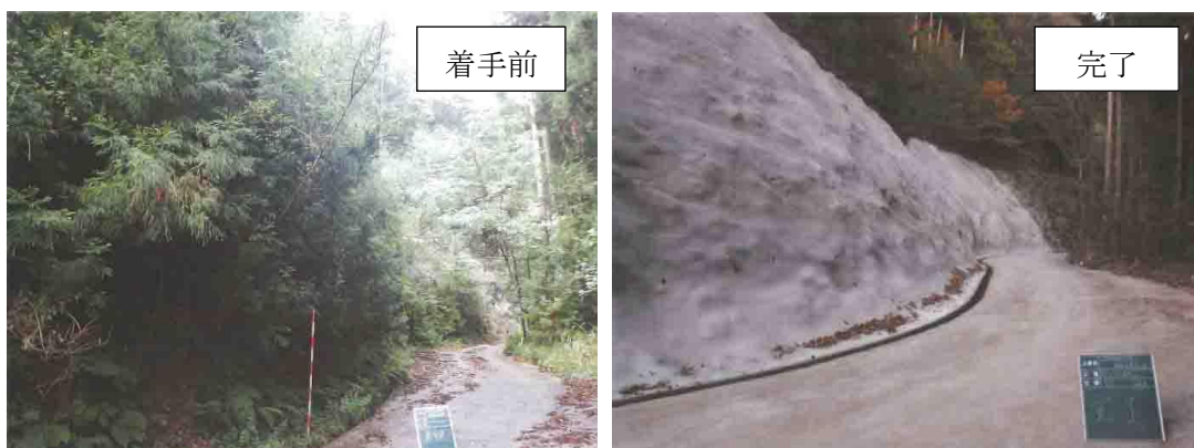
法面改良工事を進める林道東長沢線（川向地内）
