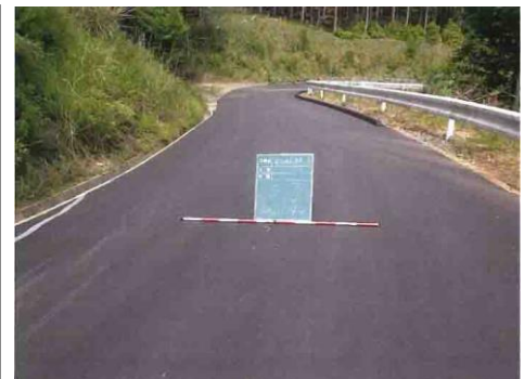
林道中口尤線 舗装状況
