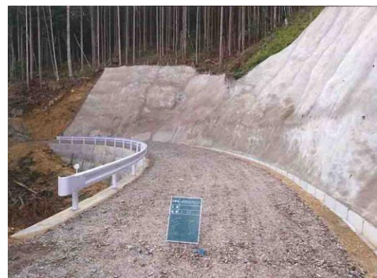
林道笹頭山線 開設状況
